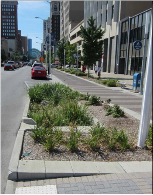
STORMWATER PLANTER INSTALLATION<sup>5, 6</sup>
